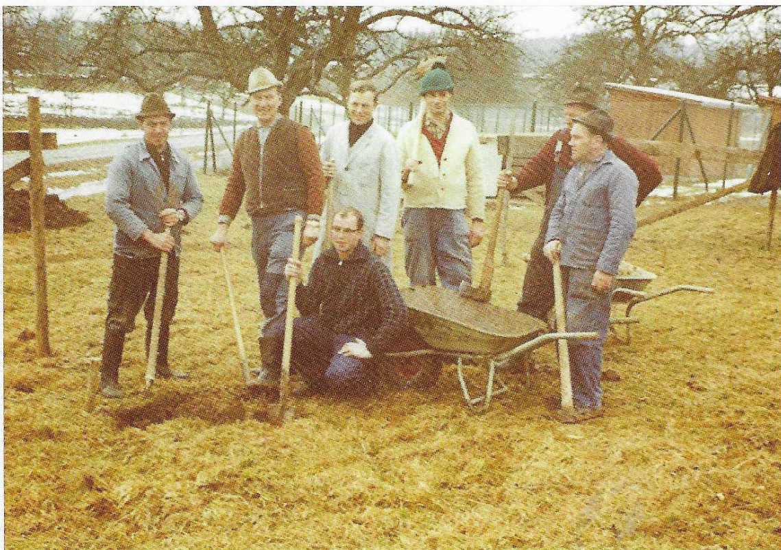
Erster Spatenstich Vereinsheim
